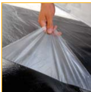
Retirar film de la M.A.D. 4. Remove the plastic film. Retirer le film de sous-face. Retirar filme da M.A.D. 4.
