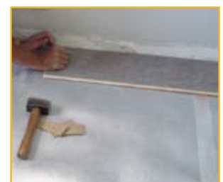
Colocar la primera hilada. Lay down the first line. Poser la première rangée. Colocar a primeira fileira de pavimento.
