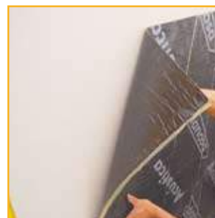
Presionar fuerte sobre la placa. Press the M.A.D. 4 against the wall. Appuyer avec force sur la M.A.D. 4. Pressionar forte sobre a placa.
