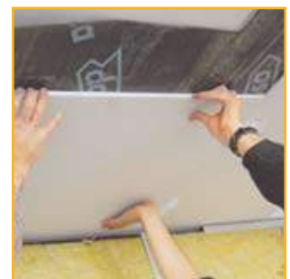
Colocar la 2ª placa de yeso. Apply the second dry plasterboard. Placer la 2ème plaque. Colocar a 2ª placa de gesso.
