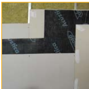
Pared sandwich acústico. Wall with acoustic sandwich. Mur avec sandwich acoustique. Parede sandwich acústico.
