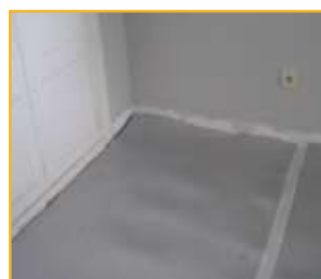
Sellar la junta a testa. Seal the joints. Ponter les joints. Selar as sobreposições.
